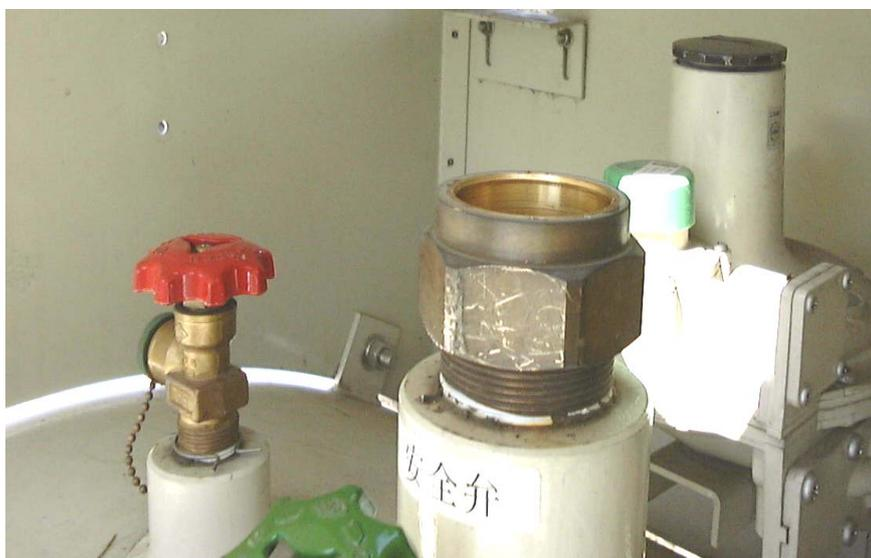
作業 3-2-⑥ 安全弁を外した後は連結弁内に異物が入らないように綺麗な布等を連結弁に被せてください。
