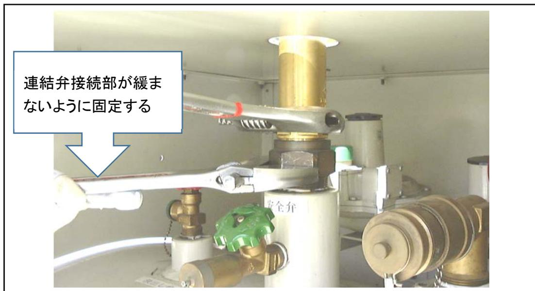
作業 6-3-② そのまま安全弁を締め込み連結弁と安全弁の隙間が無くなったら、安全弁六角部にスパナを掛けて時計回り(右回り)に軽く増し締めしてください。増し締めを行うときは必ず連結弁をスパナで固定した状態で行ってください。(締付トルクは「資料 2」参考)
