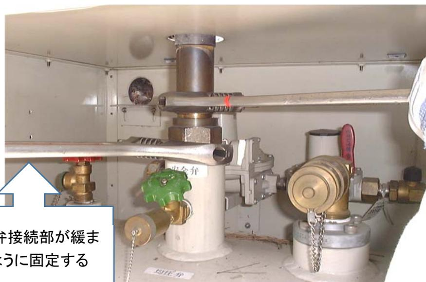
連結弁接続部が緩まないように固定する
