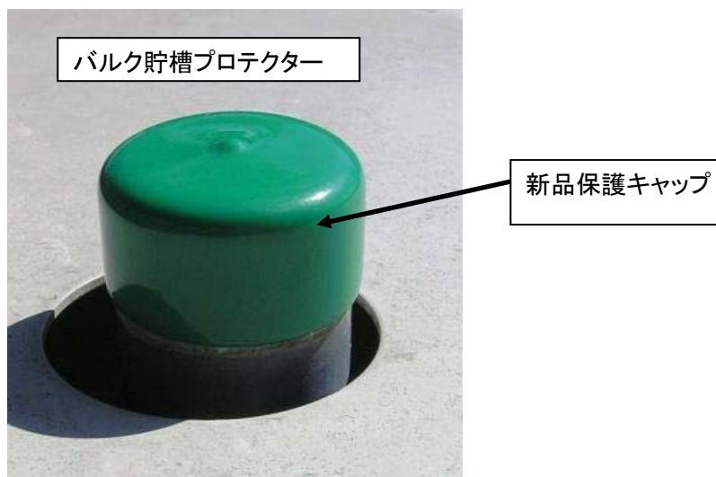
写真12 放出管に保護キャップを取り付けた状態
