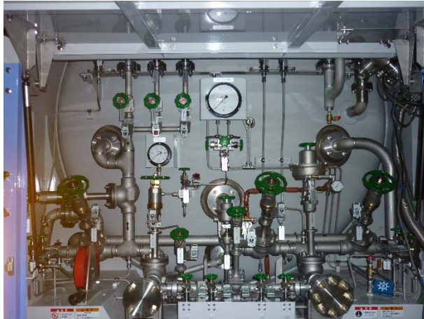
実機状況(LNGタンクローリー)
